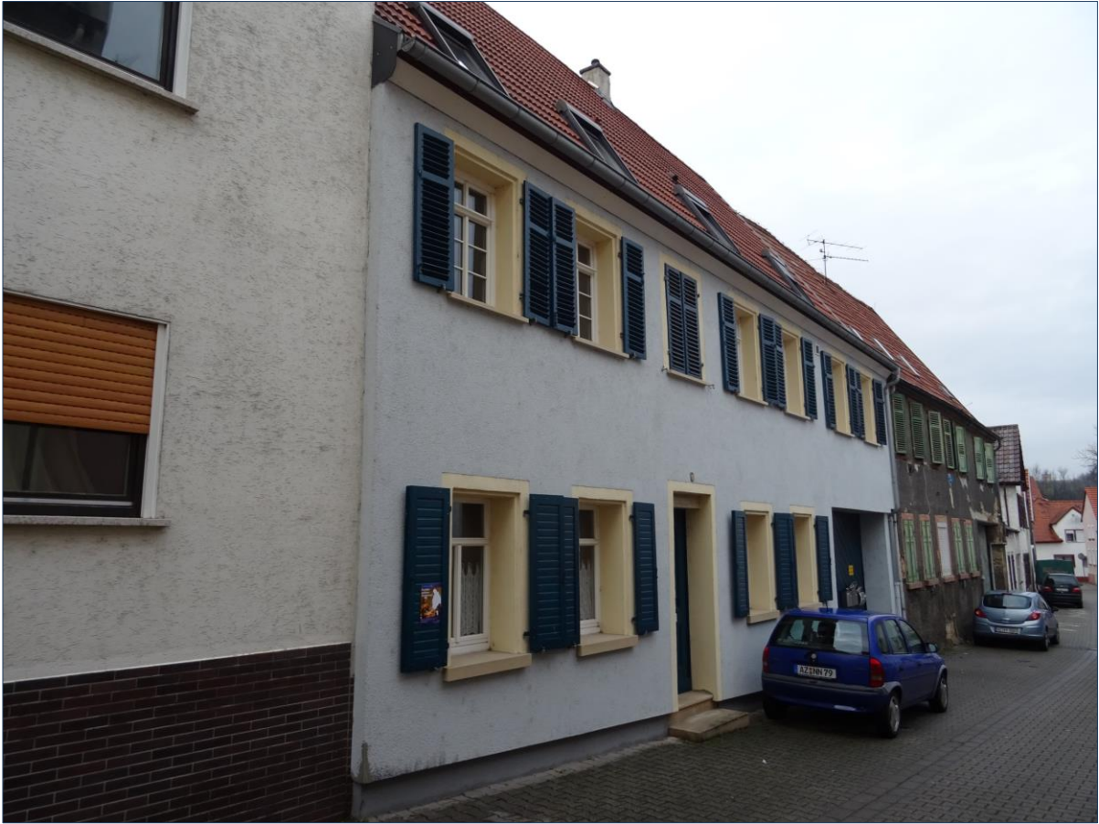
Auf die Fassadengliederung abgestimmte Dachflächenfenster
