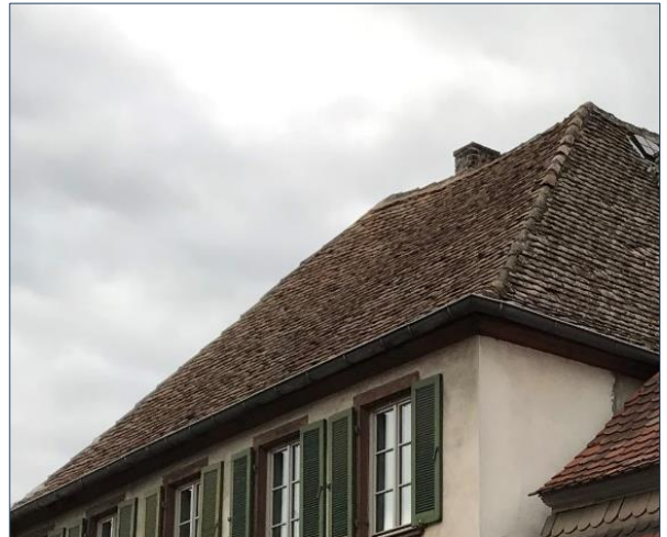
Historisches Dach mit ausgebildeter Patina
